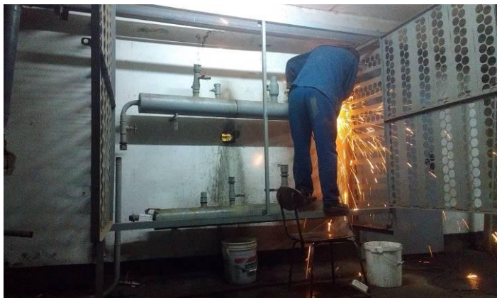
Разводка ГРЕБЕНКИ на отдельные ветки собственников
