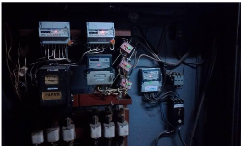
Установка счетчиков на отдельные ветки собственников
