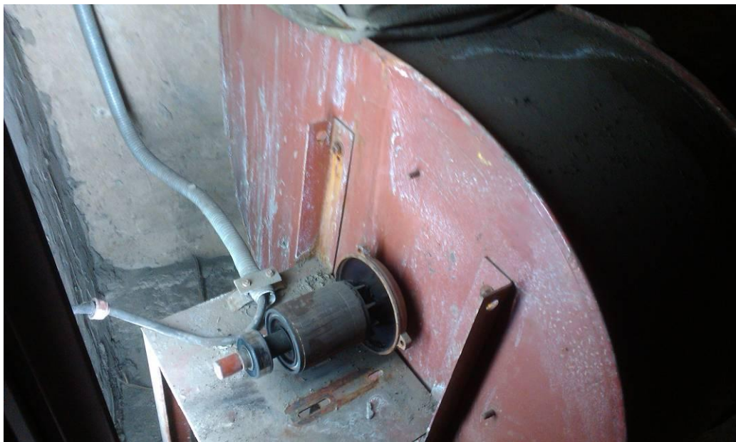
Ремонт двигателей вытяжной вентиляции.
